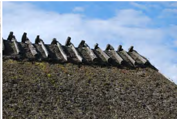
Vagnboden invändigt, längst bort skymtar dasset som är inbyggt i huset. Till höger vasstaket med ny mörning av linhalm. MOW
