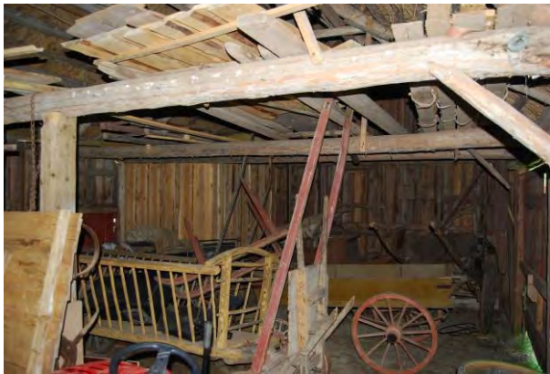
Vagnboden invändigt, längst bort skymtar dasset som är inbyggt i huset. Till höger vasstaket med ny mörning av linhalm. MOW
