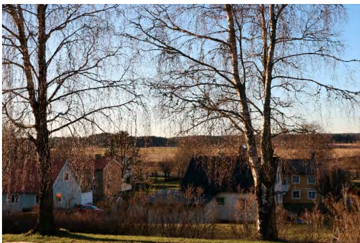
Exempel på omkringliggande bebyggelse. Bilden visar flera enbostadshus väster om planområdet och delar av väg 172, sett ifrån den östra delen av planområdet.
