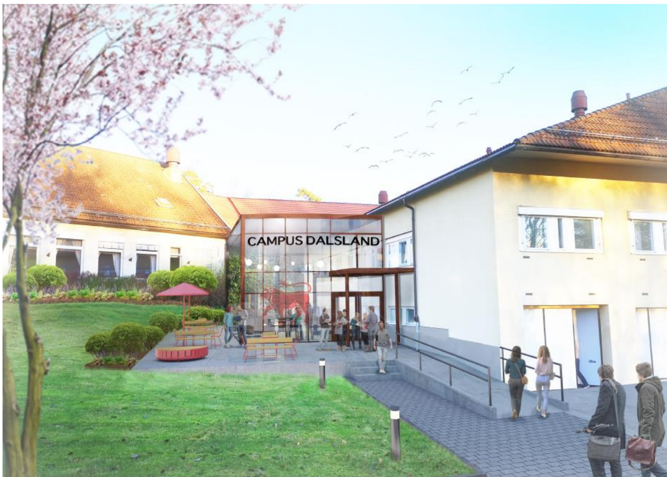
En ny inglasad tillbyggnad ger möjlighet till en ny entré och bidrar till att skapa en ljus och dynamisk miljö för studier, möten, fika, lunch etc. Bild: Contekton Arkitekter
