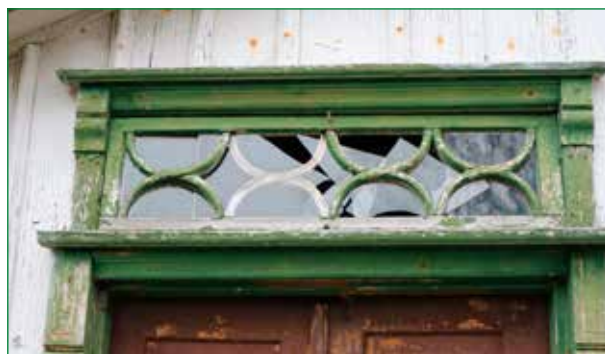
Överljusfönster på bostadshusets snedtäcka.
