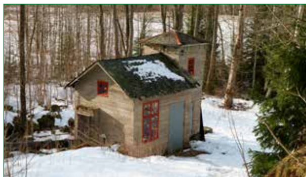
Den nedre kraftstationen.
