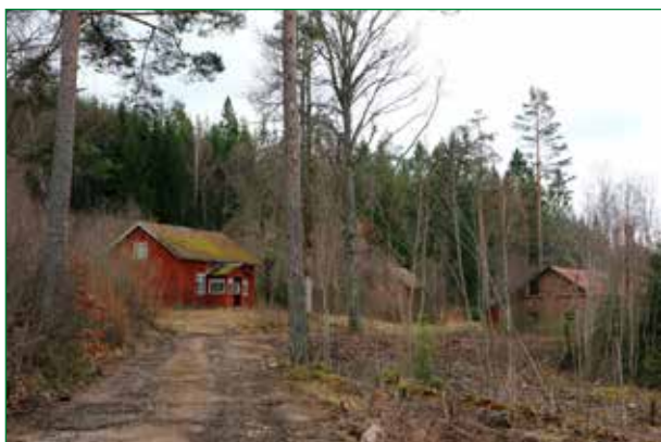
Översikt över byggnaderna.
