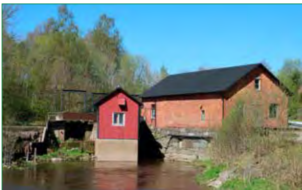
Kraftstation och kvarn på Ellenö 1:1.
