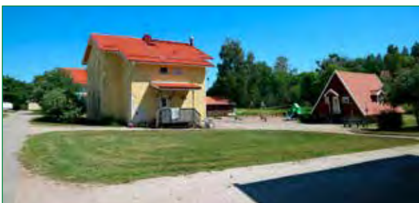
Värmecentralen till höger i bild.
