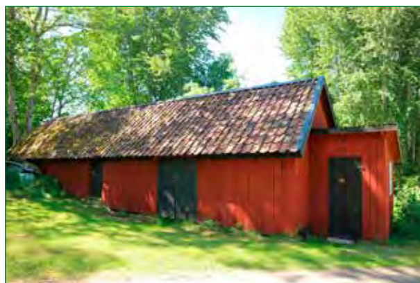
Ved- och snickarbod.
