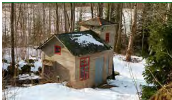
Den nedre kraftstationen.
