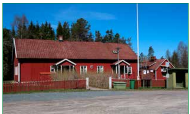
Före detta folkskolan i Råggärd och de före detta lärarbostäderna till höger i bild.
