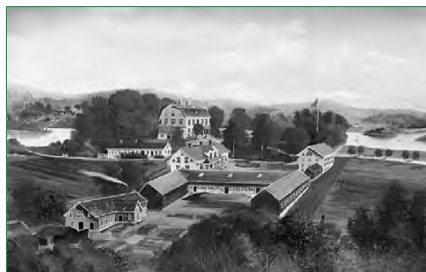
Ellenö gård. Källa Riksantikvarieämbetet.
