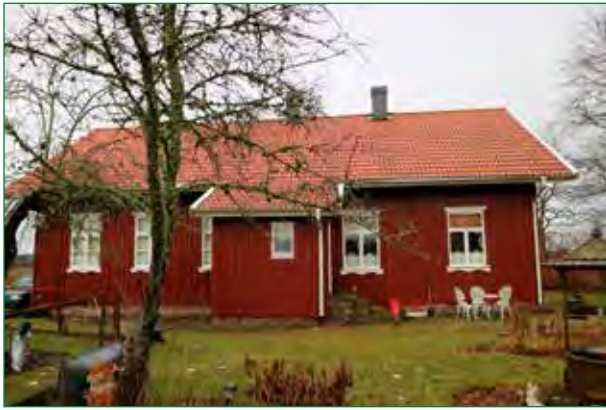
Före detta skolbyggnad, nu bostadshus.
