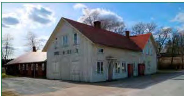
Lagerbyggnad och bostadshus.
