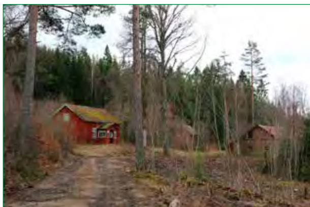
Översikt över byggnaderna.
