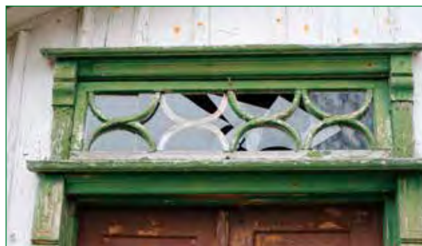
Överljusfönster på bostadshusets snedtäcka.
