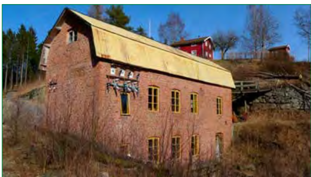
Bild från Riksantikvarieämbetets bebyggelseregister BeBR, 2015. http://www.bebyggelseregistret.raa.se/bbr2/anlaggning/visaSelectedAnlaggningFoto.raa?anlaggningId=21000001029540&fotoId=21500001461758
