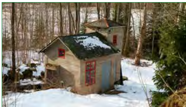
Den nedre kraftstationen.
