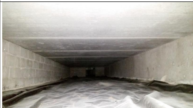
Kontroll utförs i krypgrund. Väldigt torrt klimat i krypgrunden.
