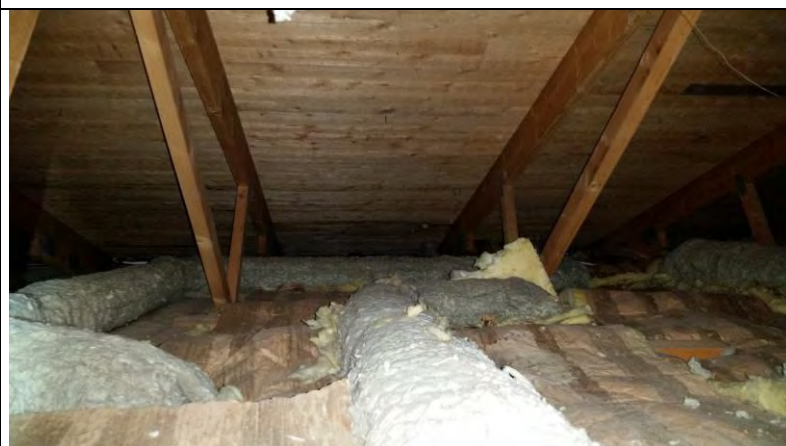
Kontroll görs också på kallvind som bedöms vara i god kondition.
