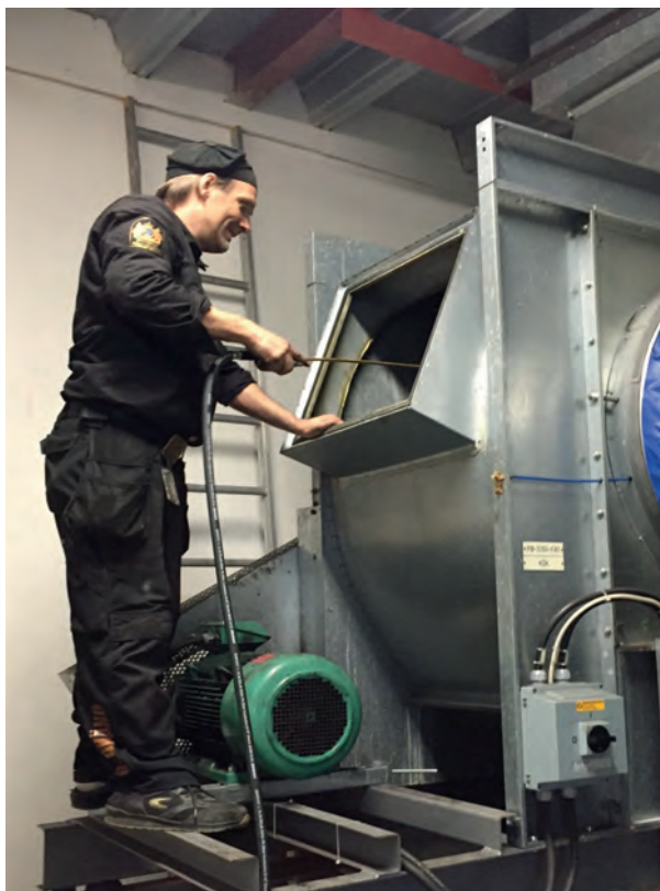
Rensningsarbete utförs av vår skorstensfejartekniker, Foto: NÄRF
